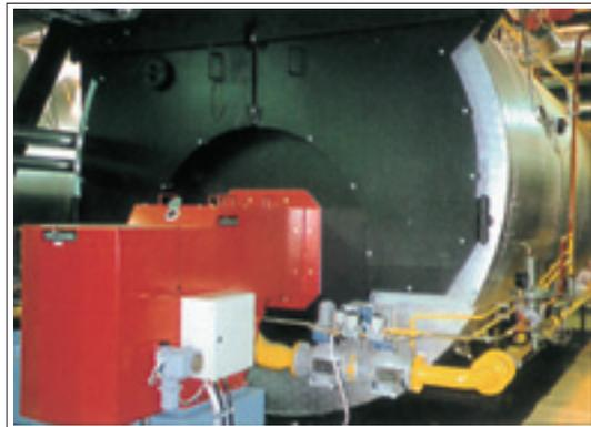
*Кунгур, Пермь, Россия, теплоцентральный. Комбинированные газомазутные горелки: 3 шт. горелки GRP-1000 ME по 10 Мвт и 3 шт. горелки GRP-700 M по 7 Мвт.*
