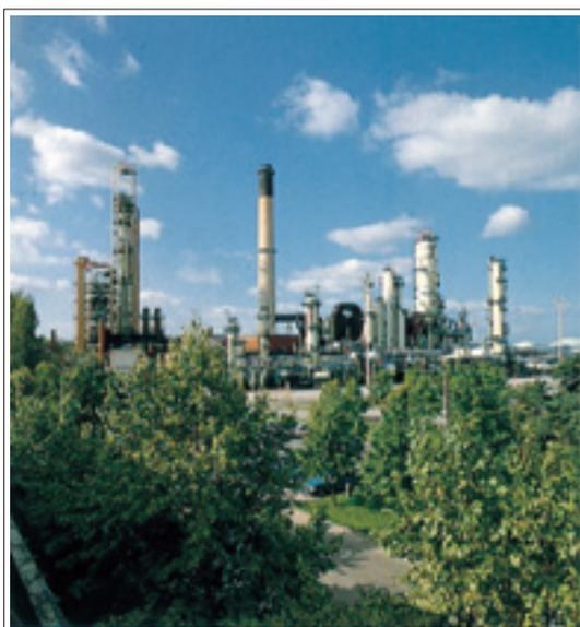
*АО Несте, г. Порвоо, Нефтеперерабатывающий завод, паровая электростанция 150 т/час. 3 шт. горелки GT-50 S Low-NO<sub>x</sub> на природном газе или на газе перерабатывающего завода. Показатель NO<sub>x</sub> на всех диапазонах мощностей ниже 50 мг (NO<sub>2</sub>)/МДж*
