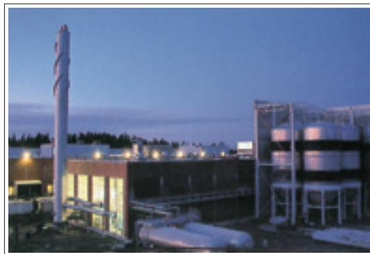
*Энергораспределительная компания г. Кервава: теплоэлектростанция Савио. 2 комбинированные горелки GKP-800 ME по 8 Мвт на газе и дизельном топливе. Установка находится рядом с пивным заводом Синебрюхофф и производит для нужд завода электроэнергию и тепло.*
