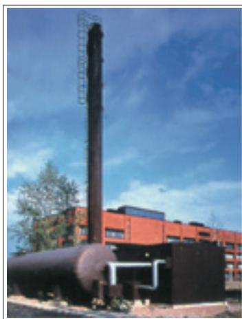
*Энергораспределительная фирма г. Форсса. Передвижная теплоцентральный 2 x 2,0 Мвт, 2 шт. мазутных горелок RP-201 H*
